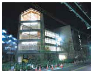
完成間近のバースクリニック。三角屋根の最上階がレセプションホール
