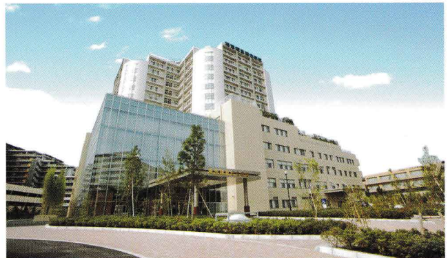
写真 湘南鎌倉総合病院 外観
